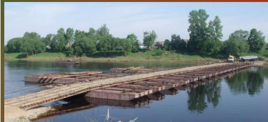
НАПЛАВНОЙ ЖЕЛЕЗНОДОРОЖНЫЙ МОСТ (НЖМ-56)
