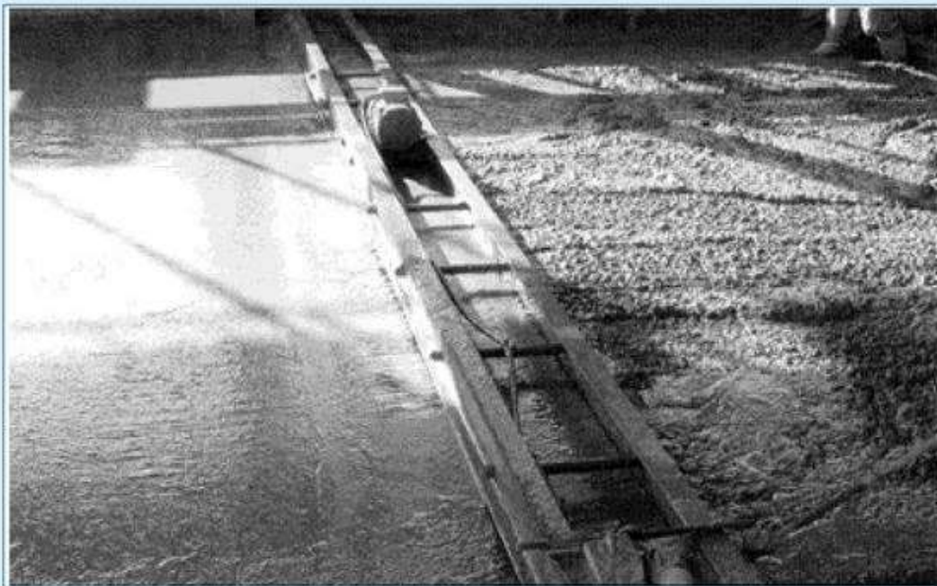
Классический способ укладки сталефибробетона при помощи виброрейки
