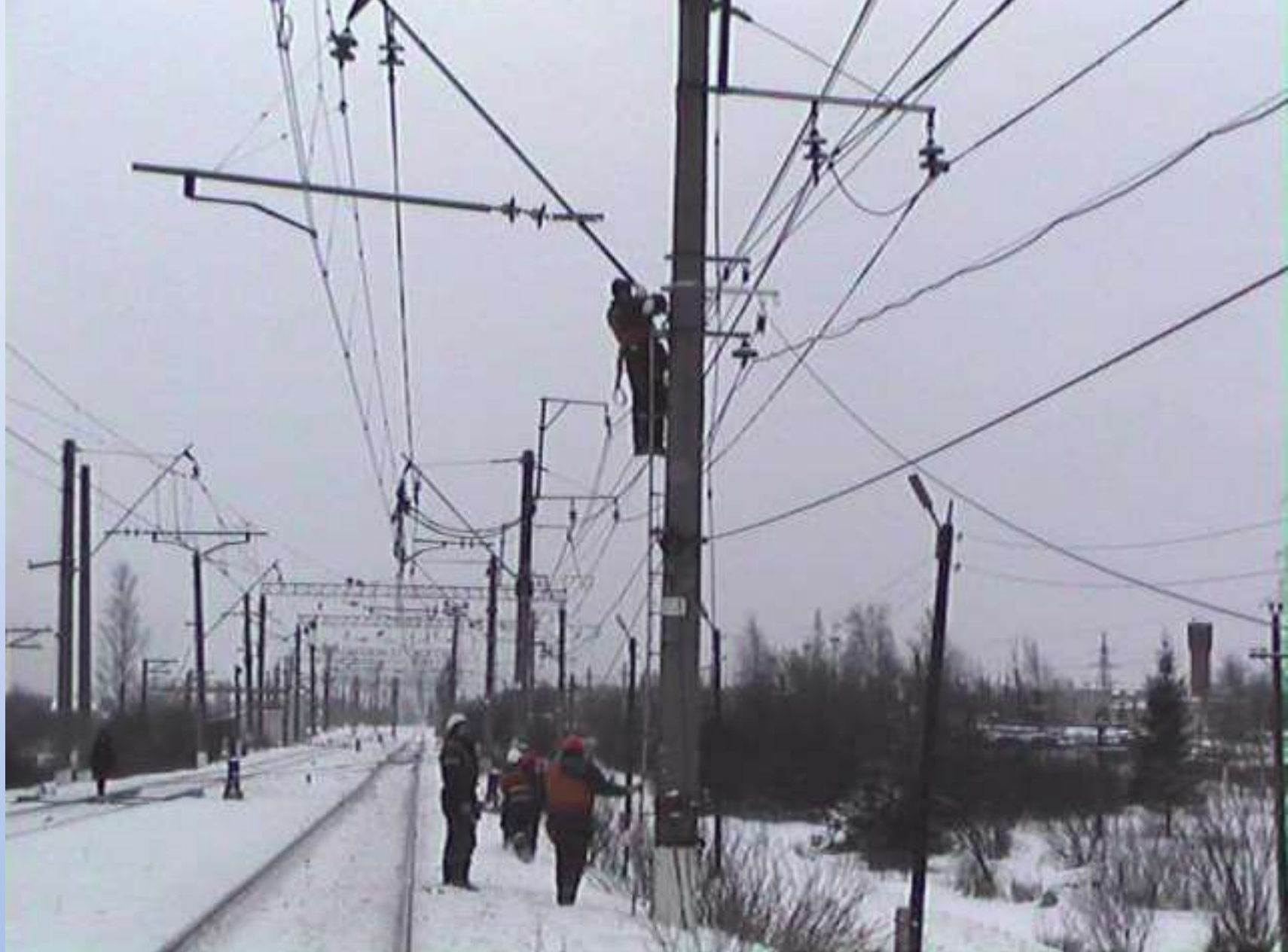
Ознакомление с особенностями подвески волоконно-оптического кабеля на опорах контактной сети
