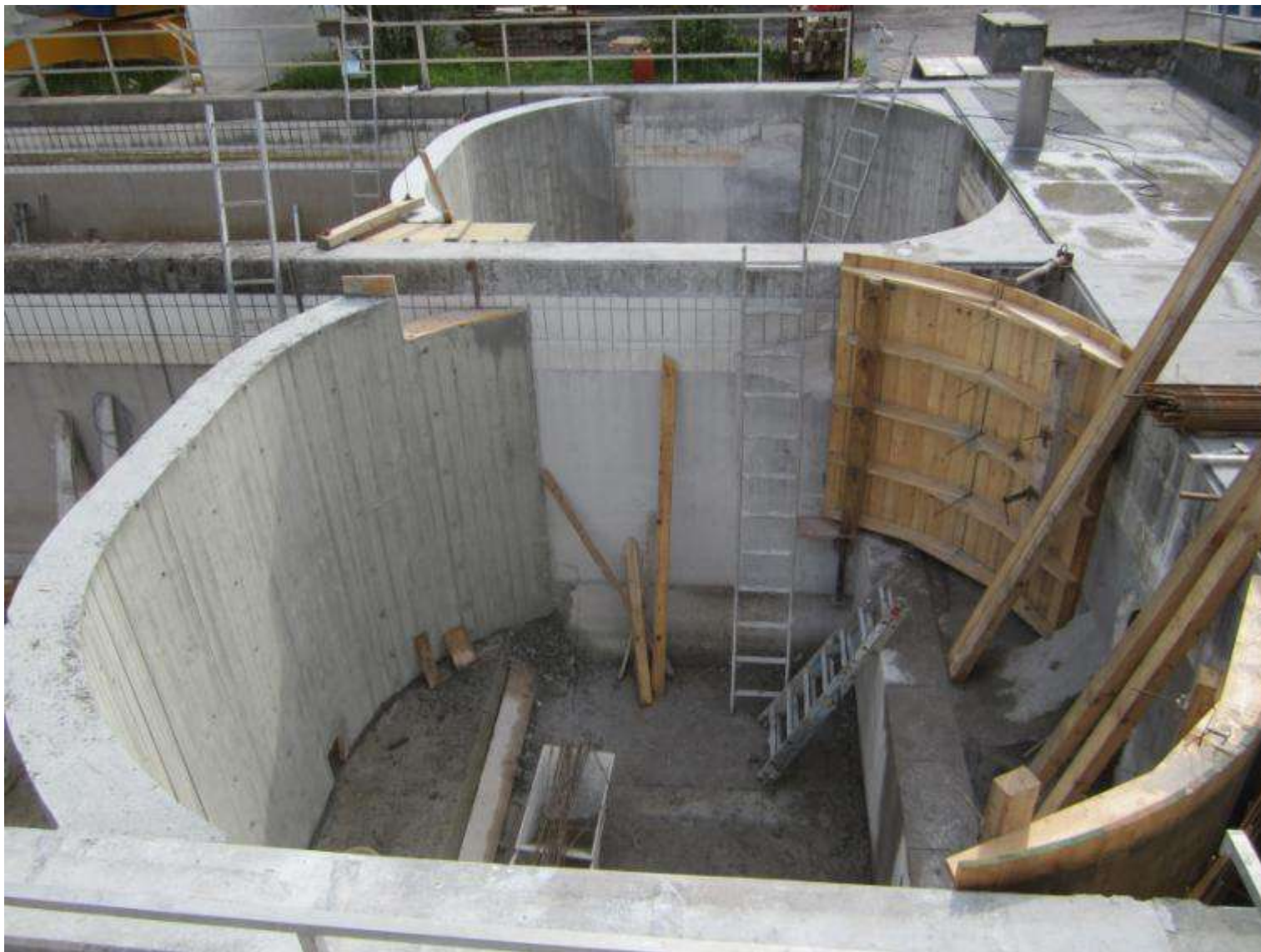
Устройство зон ила из железобетона
