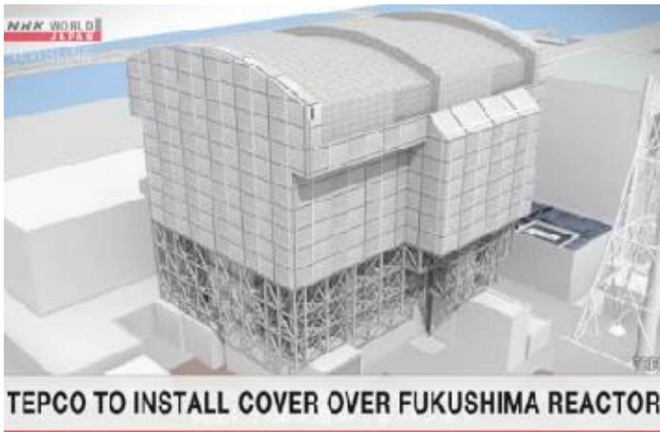
Укрытие будет иметь следующие параметры: длина 65 м, высота 65 м, ширина 50 м. Крышу оборудуют подъемными кранами для извлечения обломков.
