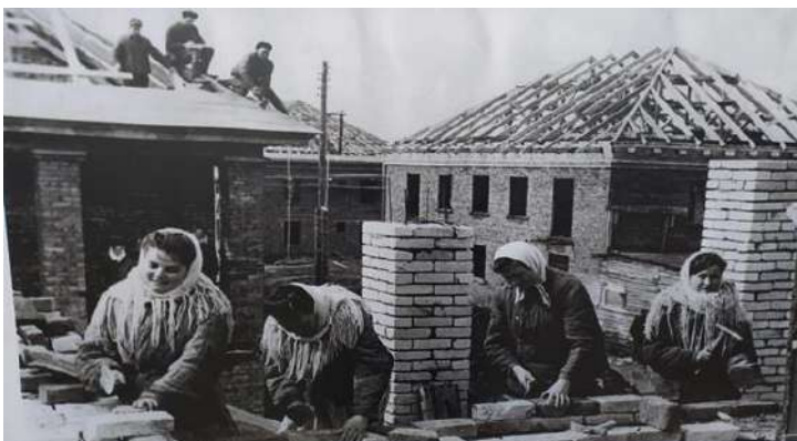
Рисунок 1 – Строительство жилых домов. Минск, 1947 г.
