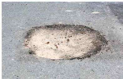
Рисунок 2 – Повреждения состояния асфальтобетонного покрытия:
