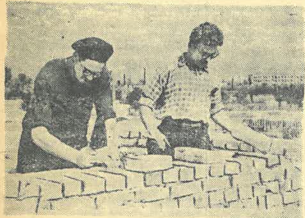
На снимке: (слева направо) студенты факультета промышленного и гражданского строительства А. Чмиль и Э. Ребиков на кладке стен 32-х квартирного дома.
