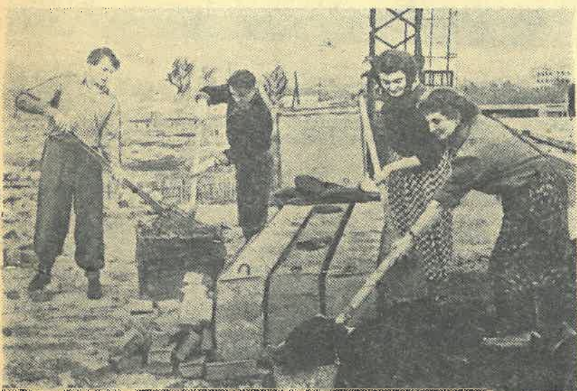
Студенты группы С-22 на строительстве общежития. Идут работы по возведению стен третьего этажа. На снимке (слева направо): студенты П. Москалев, Г. Осадчий, Н. Костечко, Л. Радченко.
