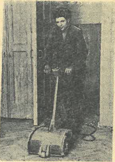
★ Острожка пола паркетно-строгальной машиной. Столяр Борнов Н. Н.
